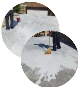
Attendi circa 6 ore fino a quando le superfici sono completamente asciutte. Ripeti la sequenza di applicazione dell'Allume Fissativo e di Calcelatte Cool Roof come descritto sopra (FASE 3).
