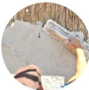
Dopodiché si applicheranno due mani di finitura. L'ultimo passaggio da eseguire è la stesura della tinteggiatura, e su parete esterna anche di un idrorepellente traspirante non filmogeno.
