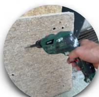
Pre-forare i pannelli attraverso punta conica da trapano liscia tipo Calcecanapa® Conical Tip, laddove è necessario applicare i tasselli.
