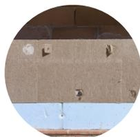
Il sistema a cappotto prevede la realizzazione di una zoccolatura di 20-30 cm di altezza dal piano di calpestio per non esporre i pannelli in fibra di canapa a umidità di risalita e spruzzi d'acqua. Pertanto è necessario realizzare una zoccolatura con pannelli di materiale non suscettibile a umidità di risalita capillare (tipo vetro cellulare espanso o XPS).
