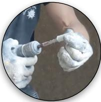
Nella fase di foratura del supporto murario, si consiglia di inserire un tubo tipo da elettricista sopra la punta da trapano per evitare che le fibre del pannello si arrotolino sulla punta stessa.
