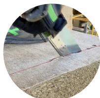
I pannelli in fibra di canapa si tagliano manualmente attraverso un coltello/cutter con lama a seghetto specifico tipo Calcecanapa® Cutter oppure meccanicamente con sega a coccodrillo a doppia lama tipo DEWALT - DT2978-QZ. Non sono adatte seghe circolari, flessibili e simili.
