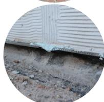
Per ottenere un allineamento maggiore e un'ulteriore barriera alla risalita capillare, si consiglia di inserire un profilo di partenza in alluminio nel contatto tra la base di partenza e il pannello isolante in fibra di canapa, il fissaggio avviene a intervalli di circa 30 cm con viti ad avvitamento. Utilizzare appositi elementi di giunzione per la base di partenza, avendo cura di non sovrapporle.
