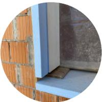
Nelle spallette delle finestre si possono applicare a pressione fasce di altro materiale isolante per correggere i ponti termici (si consiglia celenit, aereogel, ecc). In tal caso, i pannelli isolanti devono sporgere sulla superficie della facciata dello spessore dell'isolante che si andrà ad applicare nell'imbotte dell'apertura.
