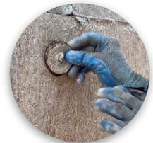
In alternativa si può utilizzare uno **strumento di taglio a lama oscillante** (tipo Utensile Multifunzione Black&Decker 300W con lama piatta) da cui si ottiene un'apertura richiudibile, dentro cui viene inserito il tassello.
