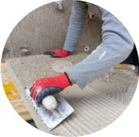
I pannelli devono essere posati in orizzontale dal basso verso l'alto, con i giunti verticali sfalsati di almeno 30 cm, tramite stesura di Calcecanapa® Pan Glue.
