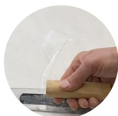
Applicare la cera nel modo più uniforme possibile con movimenti circolari, onde evitare successive tracce di applicazione.
