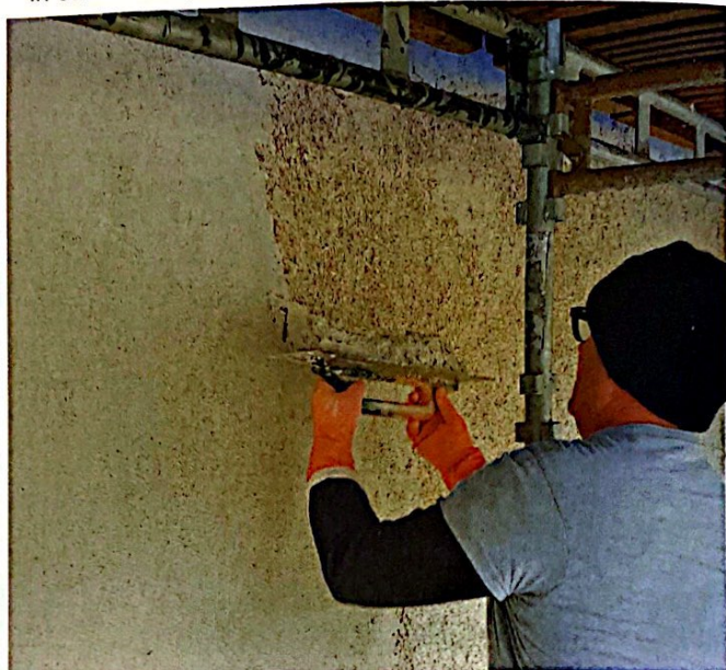
■ Applicazione a mano dello strato di finitura in calce-canapulo su muratura esterna
