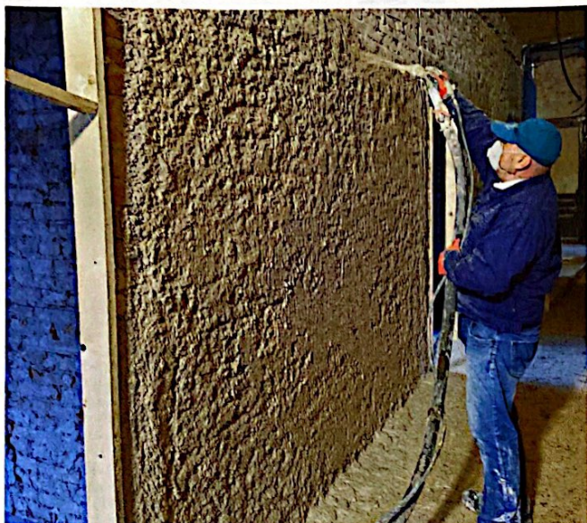
■ Applicazione a spruzzo dello strato di base (rinzafo) dell'intonaco in calce-canapulo su muratura esistente previa asportazione del vecchio intonaco
