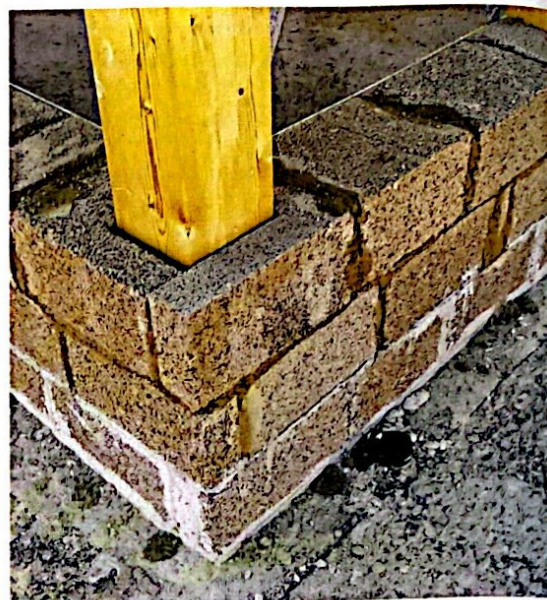
I blocchi in calce-canapulo sono facilmente sagomabili per incorporare gli elementi della struttura portante
