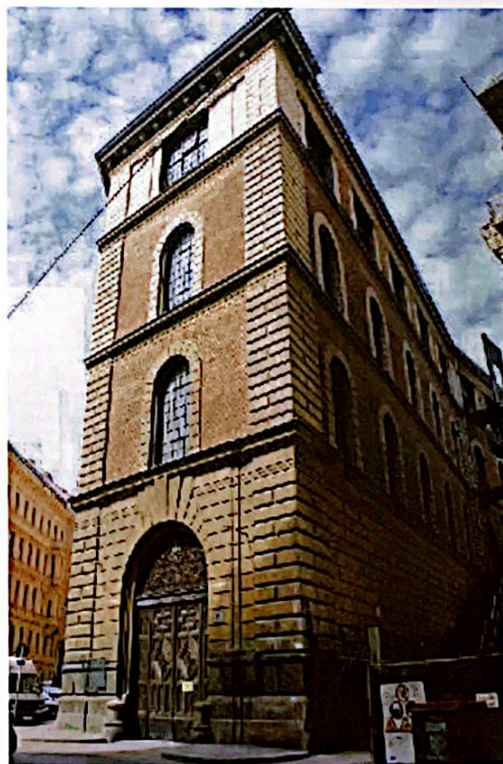
Fig. 4 - Magazzini del Court Theatre di Vienna, 1873. La magnifica facciata edificata in mattoni e elementi in Roman Cement
