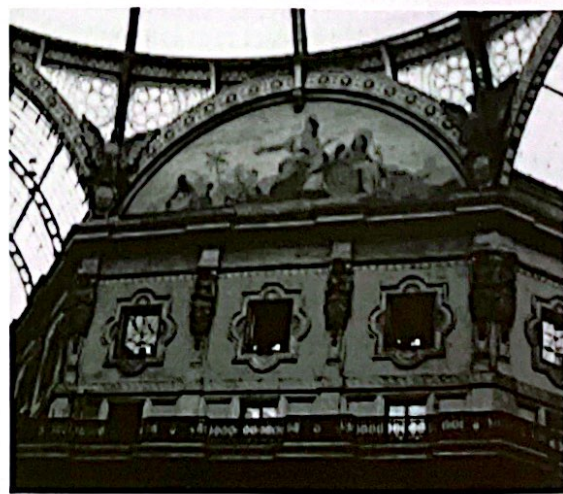
Fig. 12 - Galleria Vittorio Emanuele, Milano particolare
