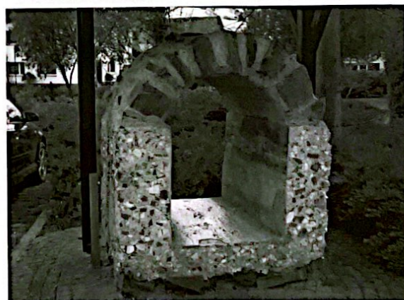
Fig. 2 - Opus caementitium romano, utilizzato per la realizzazione di acquedotti a partire dal III secolo a.C.
