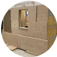
Tutti i pannelli devono essere posati in orizzontale, con i giunti di testa sfalsati in senso verticale, e ancorati alle superfici di facciata mediante stesura di Calcecanapa® Pan Glue.
