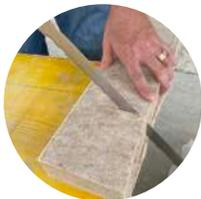
I pannelli in fibra di canapa si tagliano manualmente attraverso un coltello/cutter con lama a seghetto specifico tipo AUSONIA - cod. 55317 oppure meccanicamente con una sega a coccodrillo a doppia lama tipo DEWALT - DT2978-QZ. Non sono adatte seghe circolari, flessibili e simili.
