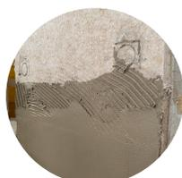
Se il supporto è complanare, si applica la malta su tutta la superficie della lastra mediante spatola a denti larghi. Se il supporto non è complanare, ma presenta irregolarità diffuse comprese tra 10 e 15 mm, si applica sul bordo perimetrale del pannello e a punti centrali, garantendo comunque una superficie minima di incollaggio pari al 40%.
