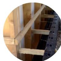
Procedere al posizionamento di un'orditura lignea, capace di assicurare l'ancoraggio del getto alla muratura.
