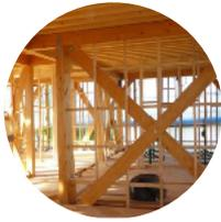
Predisporre una struttura secondaria, costituita di un reticolo ortogonale di listelli in legno, opportunamente fissati agli elementi strutturali, pilastri e travi.
