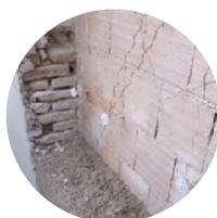
Nel caso in cui si operi su una struttura muraria esistente, la miscela, applicata allo stato umido, penetra nelle connessioni e nelle cavità del supporto e vi rimane ancorata quando solidifica.
