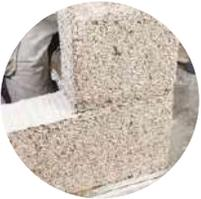
Posare i blocchi verificandone l'allineamento ed eliminare la malta in eccesso. Posizionare i blocchi in giunti trasversali (minimo 1/3 la lunghezza del blocco) applicando la malta anche lungo le superfici verticali quando ritenuto opportuno.
