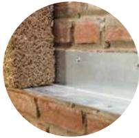
Date le elevate capacità igroscopiche di Calcecanapa® Blick, il primo corso di blocchi deve essere isolato dal terreno per evitare la risalita di umidità sulle pareti.
