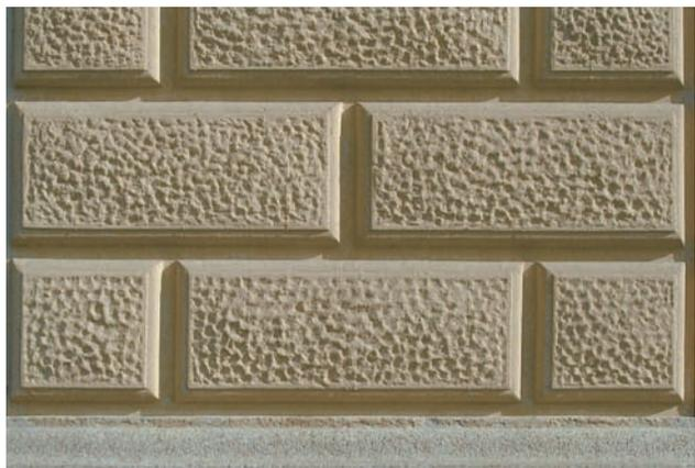
Fig. -20 - Particolare bugnato in cemento Kufstein della stazione di Bologna, oggi
