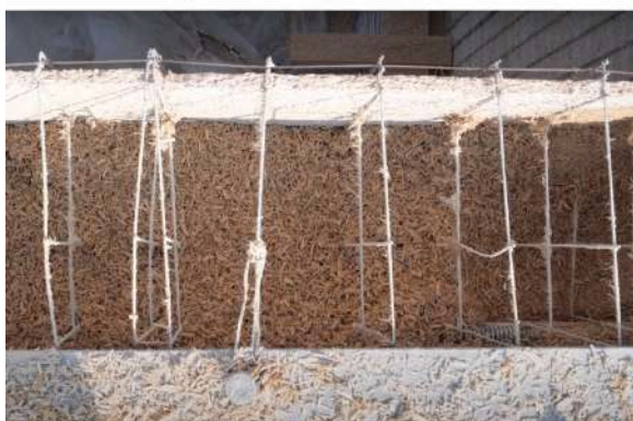
Fig. 4.24 Riempimento casseri
