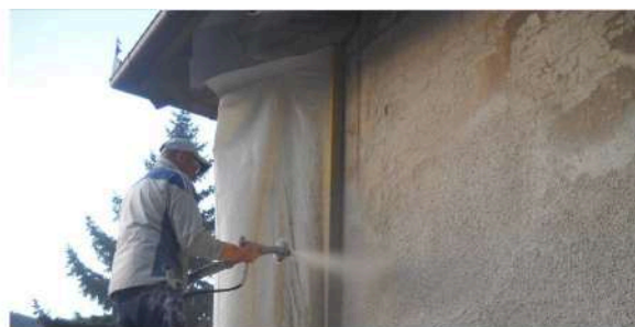
Fig. 2.29 Stesura intonaco (bancadellacalce.it)
