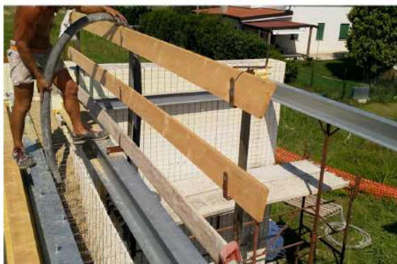
Fig. 4.22 Riempimento casseri
