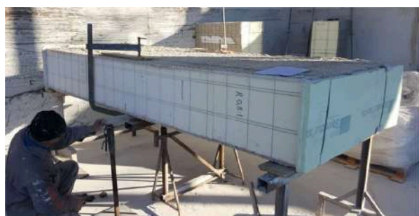
Fig. 3.10 Pannello di prova su cavalletti
