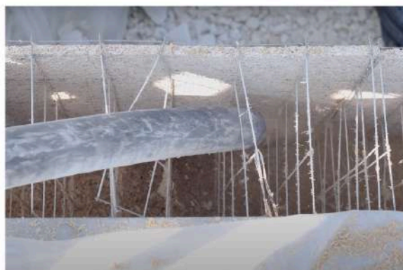
Fig. 4.23 Riempimento casseri
