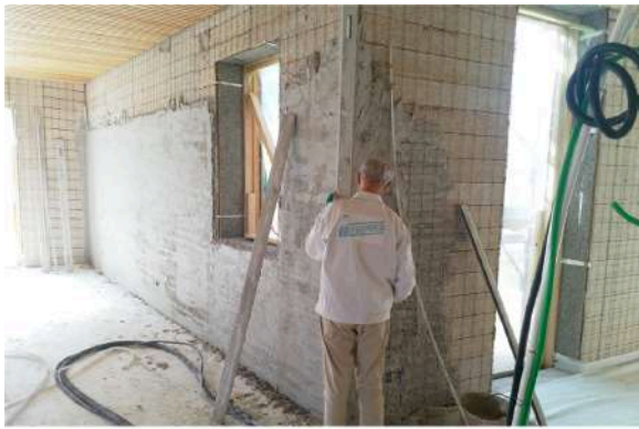
Fig. 4.28 Applicazione intonaco termico in interno
