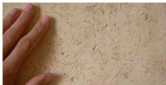
Fig. 2.31 Finitura in calce e canapa
