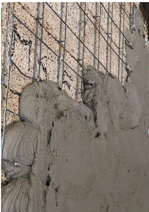
Fig. 4.32 Dettaglio intonaco termico
