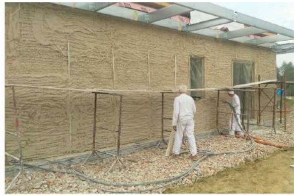
Fig. 4.29 Applicazione intonaco termico in esterno
