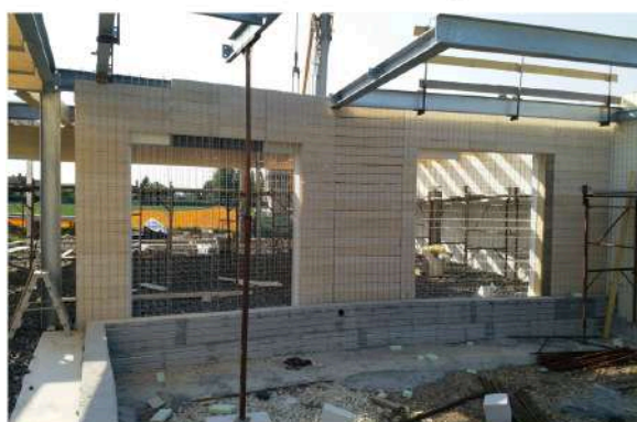
Fig. 4.13 Posa dei moduli con aperture
