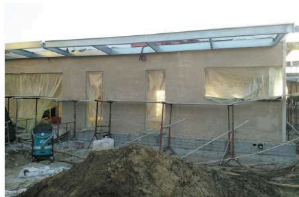
Fig. 4.31 Applicazione finitura in esterno
