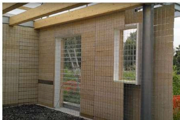
Fig. 4.12 Controtelaio per aperture
