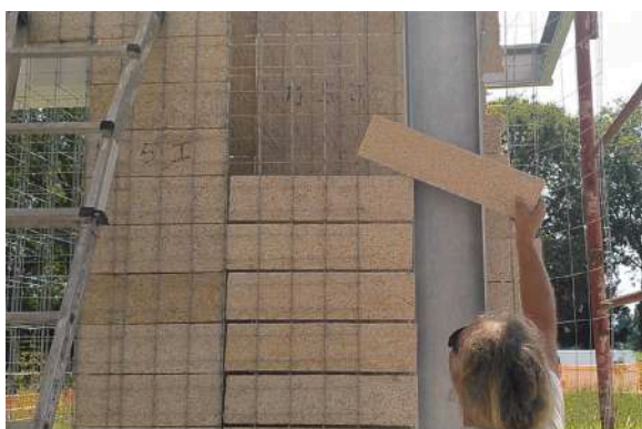
Fig. 4.15 Inserimento pannelli
